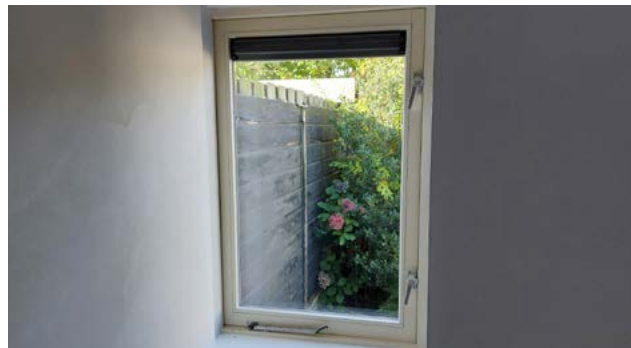
Kozijn heeft een grondverflaag
