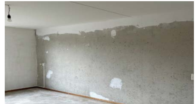
Betonnen muur met luchtbellen
