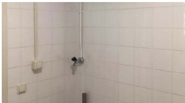
Wasmachine aansluiting
